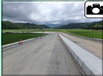
京丹後大宮ICランプ道路の路盤工を施工しています。
