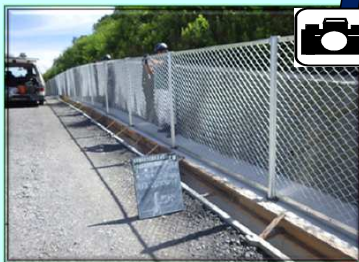
進入防止柵を設置しています。
