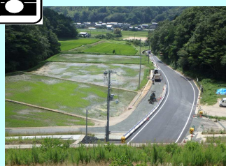
借地復旧及び府道大宮岩滝線の舗装復旧が完成しました。
