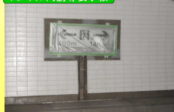
トンネル内誘導表示板
