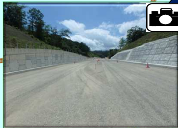
三重地内明かり部の路盤工を施工しています。
