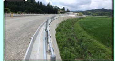
消雪設備の送・配水管を設置しています。
