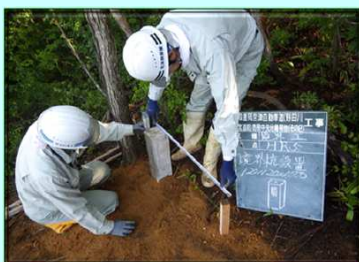
敷地境界杭を設置しています。
