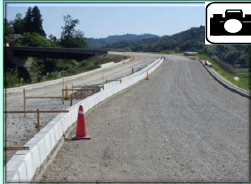
京丹後大宮ICランプ道路の中央分離帯を設置しています。
