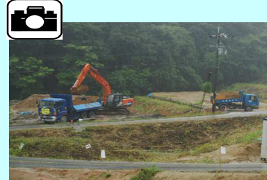
仮置きしていた残土を運び出しています。
