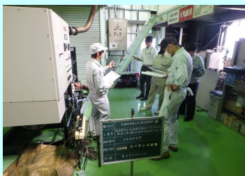
工場検査の様子です。 (上：無停電電源装置、下：自家発電設備)
