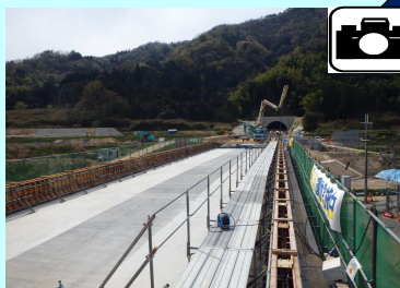
床版コンクリートの打設が完了しました。
