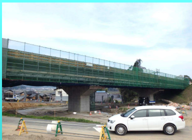
石田椎の木橋 (建設中)
