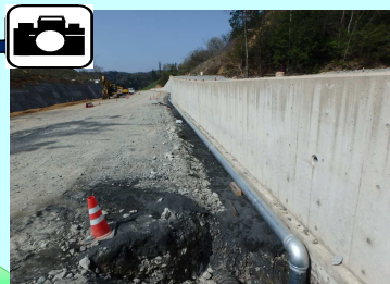
消雪用送水管を設置しています。
