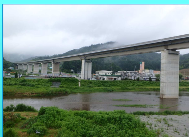
野田川高架橋
