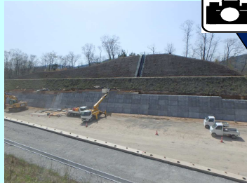
大型ブロックを設置しています。
