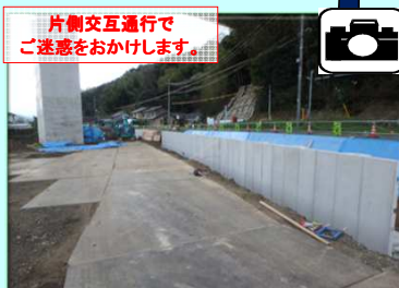
府道宮津養父線の路肩拡幅工事を実施中です。
