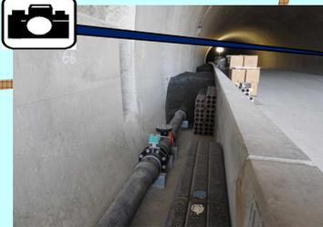
トンネル内に電線管を設置しています。(右側)
