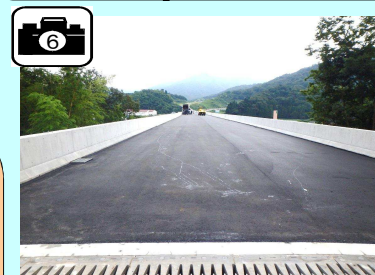
橋面舗装工事が完成しました。
