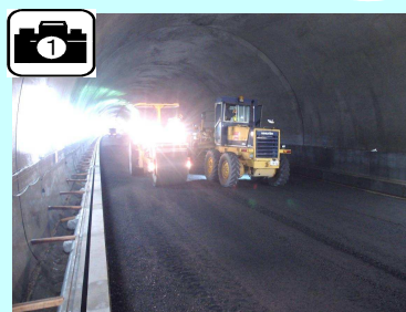
トンネル坑内では路盤を施工中です。
