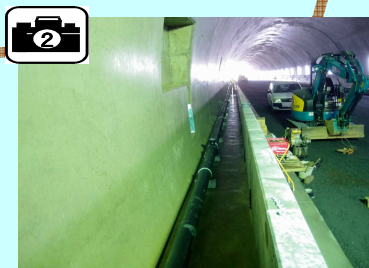
トンネル内で配水管を設置しています。
