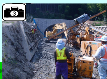
与謝野町側坑口で法面保護工事を行っています。
