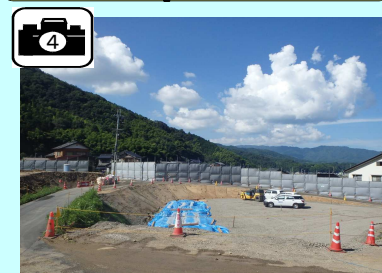
防音パネルを設置しました。
