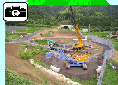
場所打杭を施工しています。
