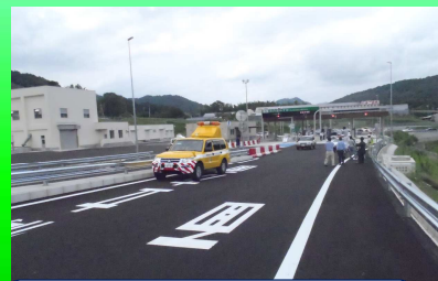
7月18日の全線開通の様子です。(京丹波みずほインターチェンジ)
