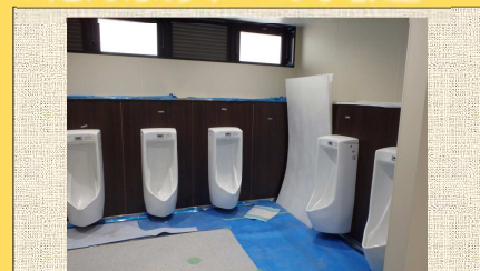
丹波PAトイレ棟内部の状況です。
