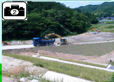
トンネル工事用のヤードはほぼ撤去出来ました。
