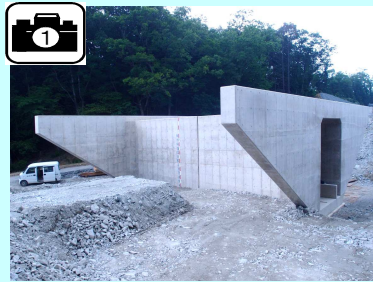
三重地内明かり部の本線下の函渠工が完成しました。
