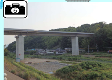
足場を撤去し野田川橋梁がきれいな姿を現しました。
