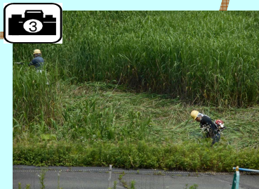
工事着手前の草刈り作業中です。
