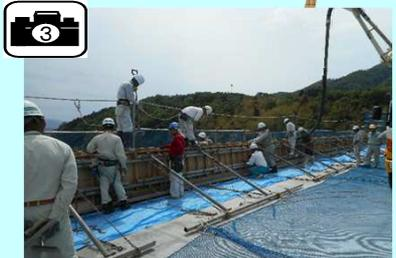
壁高欄のコンクリートを打設しています。
