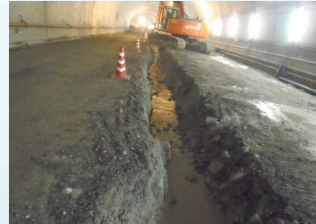
中央排水工を設置するための掘削状況です。
