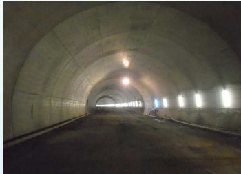
二次覆工コンクリートまで出来た状況です！
