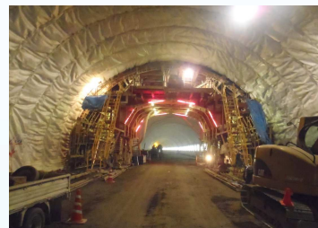
二次覆工の前に防水シートを貼っています。
