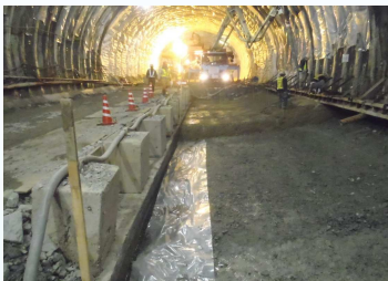
インパート(底盤)の施工中です。
