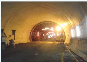
待避所の二次覆工コンクリートを打設中です。
