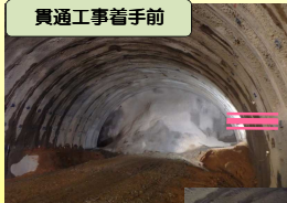
貫通工事着手前
