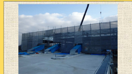
瑞穂IC料金所アイランド工事の状況です。
