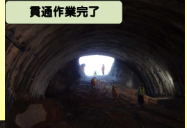
貫通作業完了
