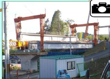
架設桁の送り出しをしています。
