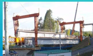
架設門構で桁を吊り上げ、所定の位置に設置します
