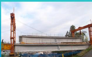
架台をレールで架設桁上へ送り出します
