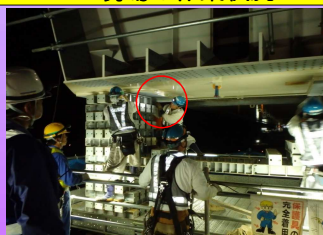
15cmのH型鋼材（サンドル）を抜いています。
