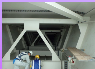
※オマケ これが橋桁の内部の様子です！
