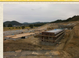
瑞穂インターチェンジ料金所建築工事の状況です。
