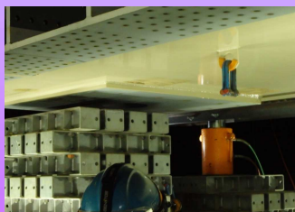
ジャッキを上げて橋桁との間にすき間を作ります。
