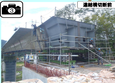
連結構切断前
