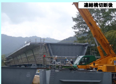
連結構切断後
