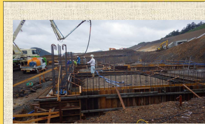
瑞穂インターチェンジ料金所建築工事に着手しました！
