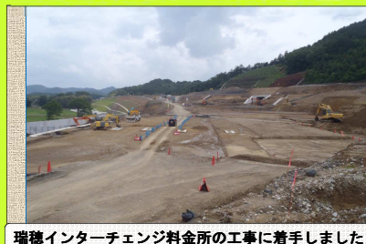
瑞穂インターチェンジ料金所の工事に着手しました！
