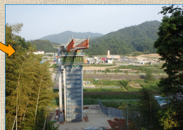
A2橋台側から見た写真です
