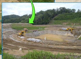
調整池の工事をしています。
