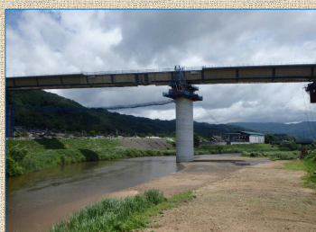
6月16日からの出水期を前に、河川内の作業ヤードを撤去しました
