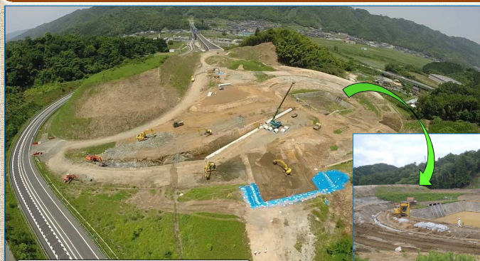
ラジコンヘリで撮影した与謝天橋立！Cの全景です。(森・辻JV提供) 奥に見えるのが野田川橋梁です！
