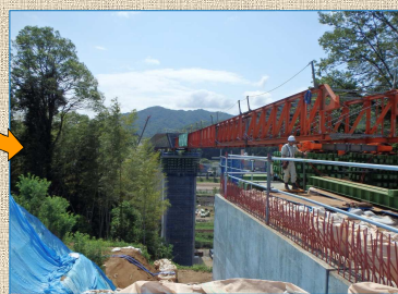
A2橋台側から見た写真です
