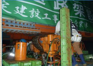
ジャッキを補助するため、各橋脚上にエンドレスローラというものを設置しています
