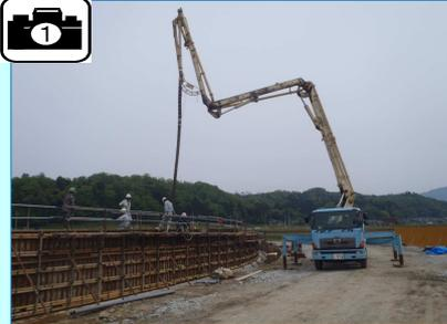
擁壁のコンクリートを打設しています。
