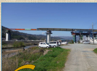
4月14日の状況 (P9橋脚に到達しました)
