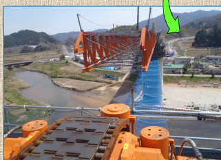
P9橋脚から見ると手延べ桁がすぐ そこまで近づいているのがわかります
