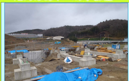
瑞穂インターチェンジ料金所の工事状況です（国施工）
