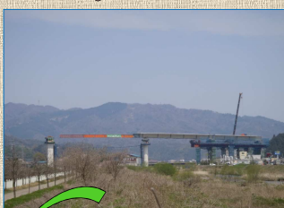
4月11日の状況 (P9橋脚まであと少しです)
