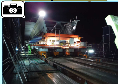
夜間の作業状況です。
