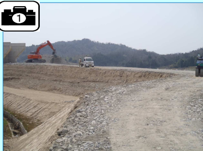
ランプ部の盛土が始まりました。
