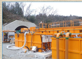
新しい濁水処理設備を坑口横に設置しました。
