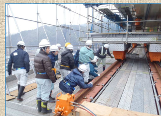
府・市・町の技術職員への 工事見学会（3月14日）
