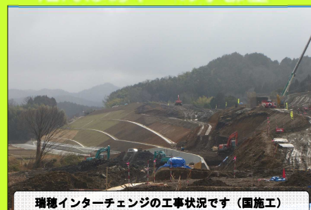
瑞穂インターチェンジの工事状況です（国施工）
