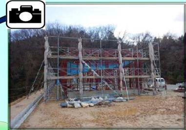
電気室の鉄骨を組み立てています。
