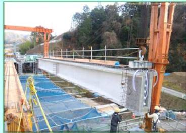
P2橋脚とA2橋台の間で桁を設置しています。
