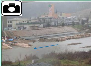
野田川の河川内の護岸を設置しています。
