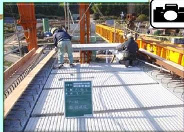
P1橋脚とP2橋脚の間でPC板を設置しています。
