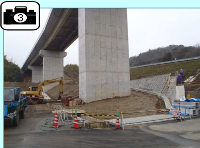
野田川橋梁下に排水路と擁壁を設置しています。
