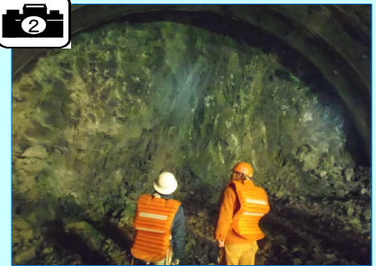
切羽(トンネル先端部)の状況です。 2月21日現在の掘削延長は1,350mです!
