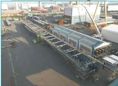
工場での仮組検査の様子です 実際に工場では桁を組み立て、設計通りに仕上がっているか確認します。
