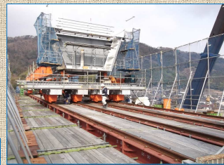
手延機・連結機の次に桁をつなぎます。
