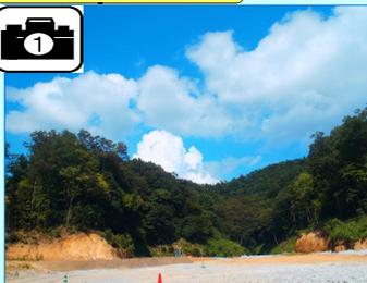
トンネル掘削残土(ズリ)により谷を埋めています。
