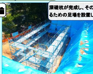
深礎杭が完成し、その上に橋台を作るための足場を設置しています。
