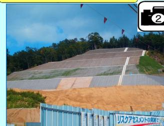
府道大宮岩滝線のすぐ横の切土工事(6段)が概ね完了しました。
