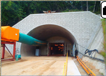
トンネルの奥に入れていた防音扉を再び入り口付近に移動しました。
