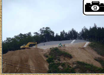
府道大宮岩滝線のすぐ横の掘削工事を進めています。降雨による土砂流出防止には十分注意しています。
