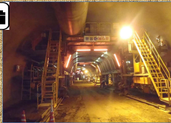
スライドセメントでトンネル覆工コンクリートを打設しています。
