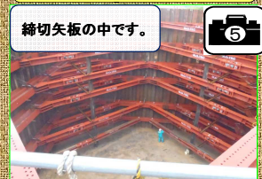
野田川橋梁P10橋脚
