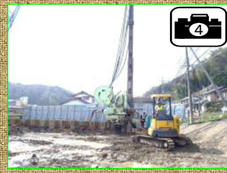
野田川橋梁 P10橋脚
