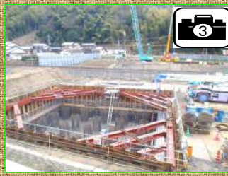
野田川橋梁 P9橋脚
