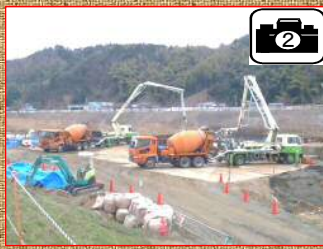
野田川橋梁 P8橋脚
