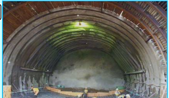
トンネルを筒状にするためのインパート（底版鉄筋コンクリート）を施工しました。
