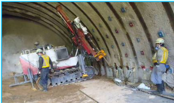
トンネル坑口部は地盤が予想以上に軟弱なことから、支保工脚部の支持力を向上させるためレグパイル工法（支保工の左右に鋼管φ250mm長さ3.5m各1本）を施工しました。
