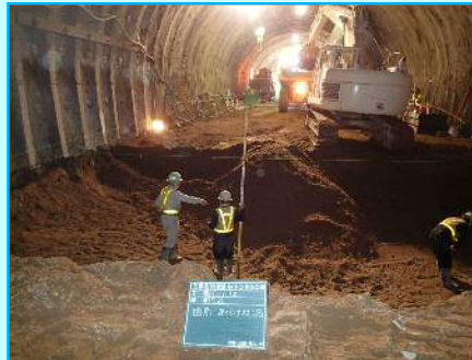
80m付近のインパートを施工しました。土砂掘削後鉄筋コンクリートを打設します。
