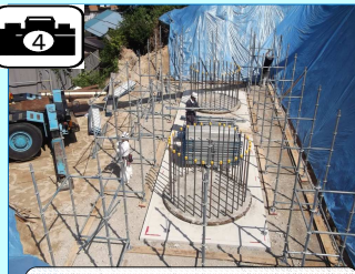
深礎杭が完成し、その上に橋台を作るための足場を設置しています。
