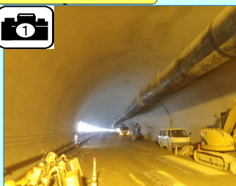
二次覆工完成区間です。
