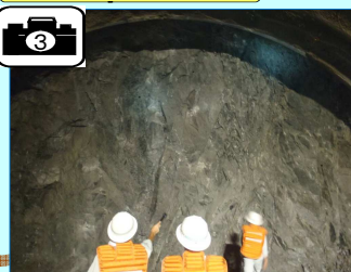
切羽（トンネル先端部）の状況です。
