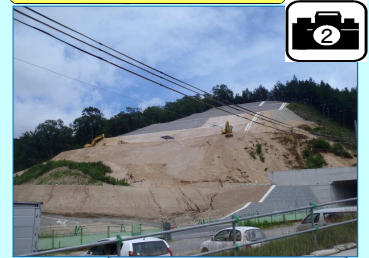
府道大宮岩滝線のすぐ横の切土工事を進めています。
