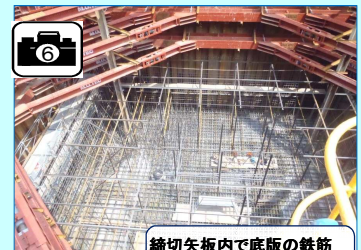
締切矢板内で底版の鉄筋を組み立てています！
