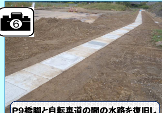
P9橋脚と自転車道の間の水路を復旧しました。
