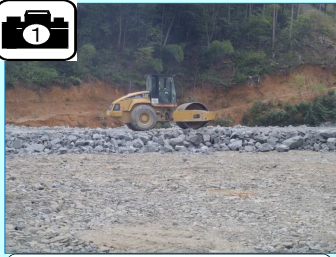
トンネル掘削土(ズリ)で道路の盛土をしています。
