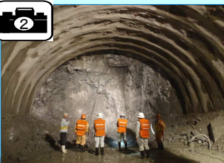
切羽(トンネル先端部)の状況です。
