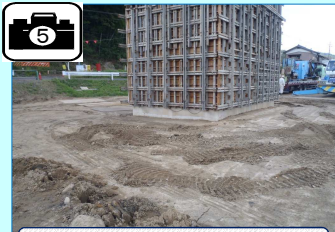
仮締切矢板の引き抜きが完了しました。
