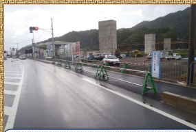
重機等の進入路として、歩道の切り下げをしました。
