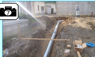
P7橋脚付近で送水管を埋設しています。
